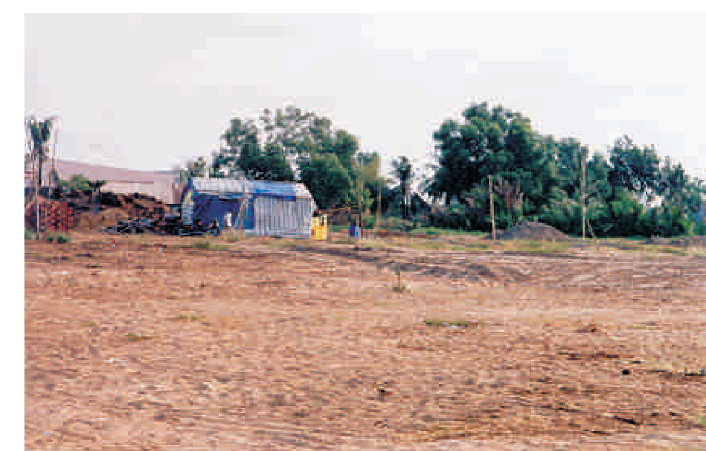
Sân lấp đất nông nghiệp để xây dựng khu dân cư
